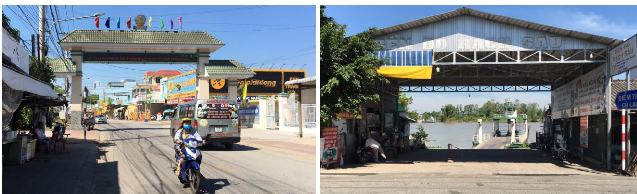
Hình: Đường Tỉnh lộ 942 và bến đò Rạch Sâu
